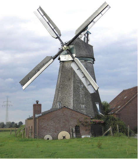
Photo: MiraculuxHB - Die Windmühle von Donsbrüggen, Stadt Kleve. Bemerkenswert sind die vertikalen Aluminiumklappen der Flügel.
